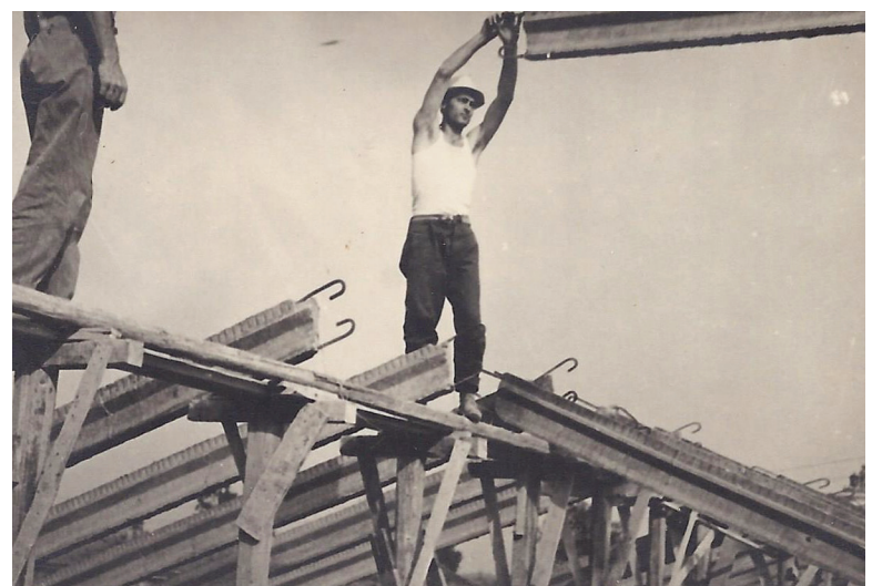
"Chile" in cantiere primi anni '60
