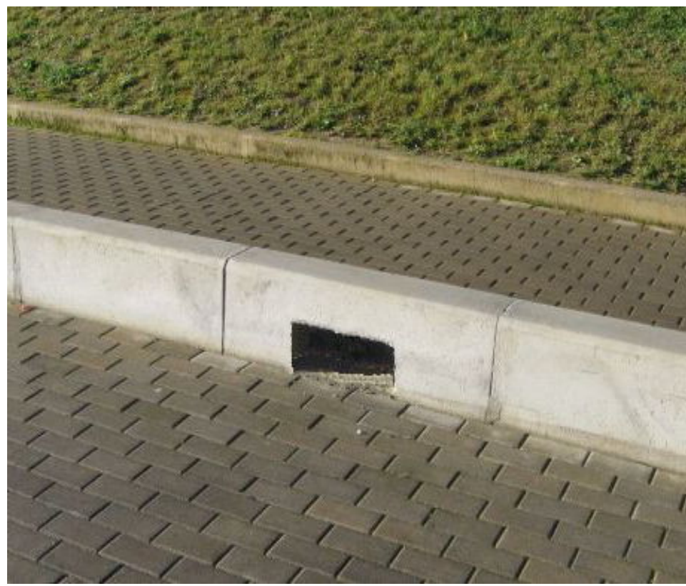
Cordoli stradali "bocca di lupo" in calcestruzzo prefabbricato cm 12/15 x 25 x 100
