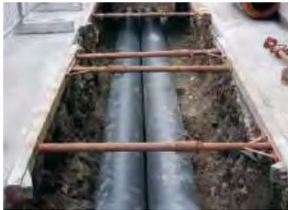
Per gli scavi in trincea superiori a 1,50 m di profondità, a protezione delle pareti dello scavo devono essere disposte armature di contenimento apposite, per esempio, utilizzando il blindoscavo, cioè pannelli metallici, sporgenti almeno 30cm dal piano stradale ed estesi fino al fondo dello scavo (si veda la figura).
