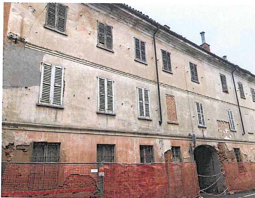
Vista da Via Cavour
