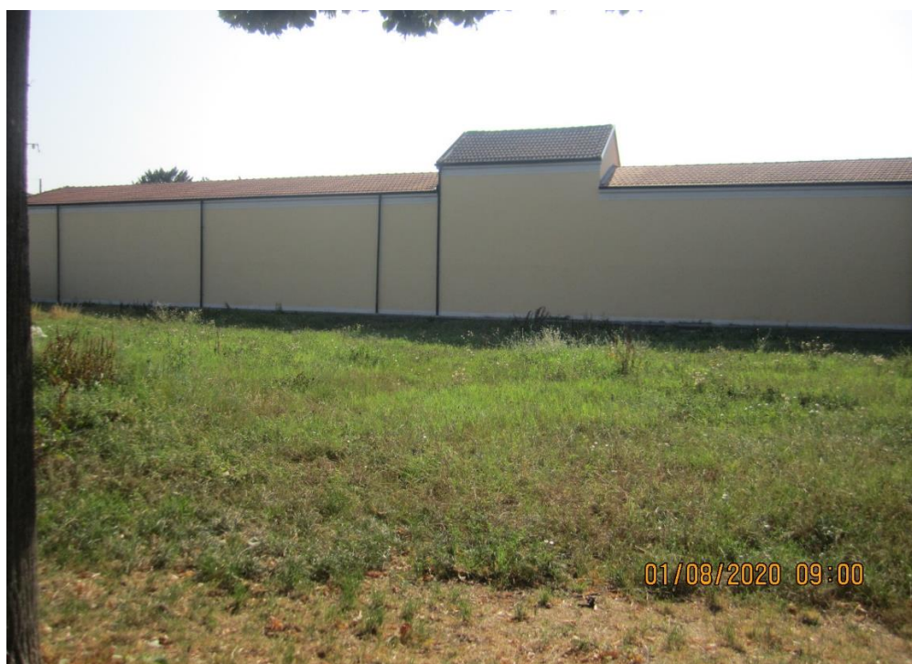
VISTA DELL'AREA ESTERNA DEL CIMITERO COMUNALE OGGETTO D'INTERVENTO DA VIA DEL LUCINO
